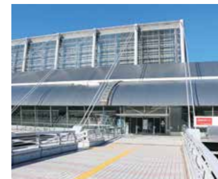
メッセモール中央連絡デッキ (展示ホール9・10前 / 2F) Messe Mall Central Bridge (Exhibition Hall 9-10 side / 2F)
