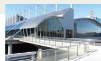
⑩メッセモール北連絡デッキ Messe Mall North Bridge
