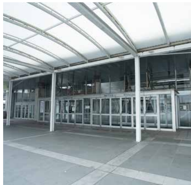
メインエントランス(2F) Main Entrance (2F)
