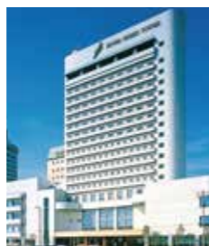
ホテルグリーンタワー幕張 HOTEL GREEN TOWER MAKUHARI ☎043-296-1122
