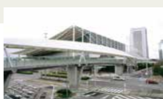
⑧国際展示場連絡橋 Pedestrian Overpass
