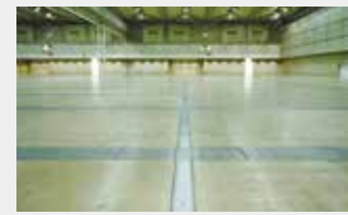
床下には、電気ピット(電気・臨時電話回線等)、機械ピット(ガス・上下水道)が交互に組み込まれている。 Electrical pits (electricity, temporary phone lines, etc.) and machine pits (gas, water supply & drainage equipment) are alternately embedded underfloor.
