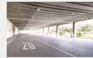
東ローディングスペース East Loading Space
