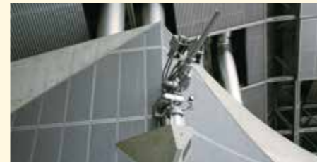
放水銃 (火災時には放水銃による消火活動が可能) Water Gun (for fire extinguishing)
