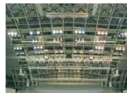
天井部には100ヶ所以上の吊フック・トラス・バトン Hanging hooks, trusses, batons in over 100 spots in the ceiling
