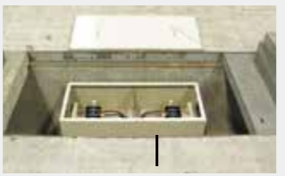
床下には、電気ピット(電気・臨時電話回線等)、機械ピット(ガス・上下水道)が交互に組み込まれている。 Electrical pits (electricity, temporary phone lines, etc.) and machine pits (gas, water supply & drainage equipment) are alternately embedded underfloor.
